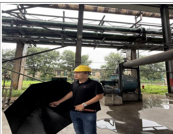
工程师现场踏勘照片（2）
