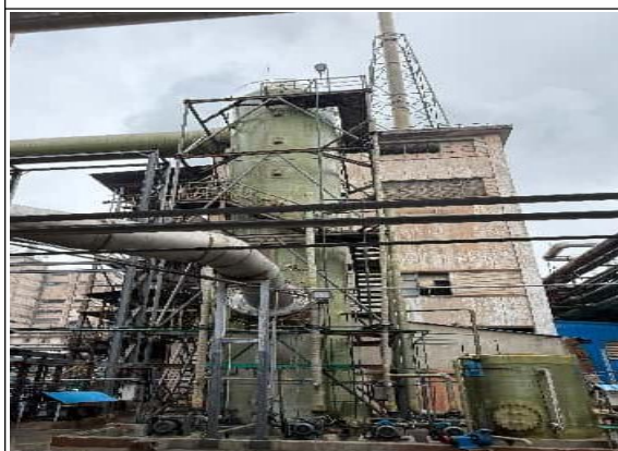
项目脱硫塔现状照片
