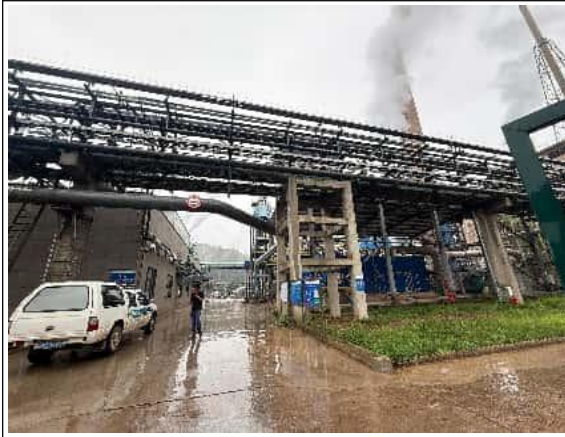
项目大门入口处
