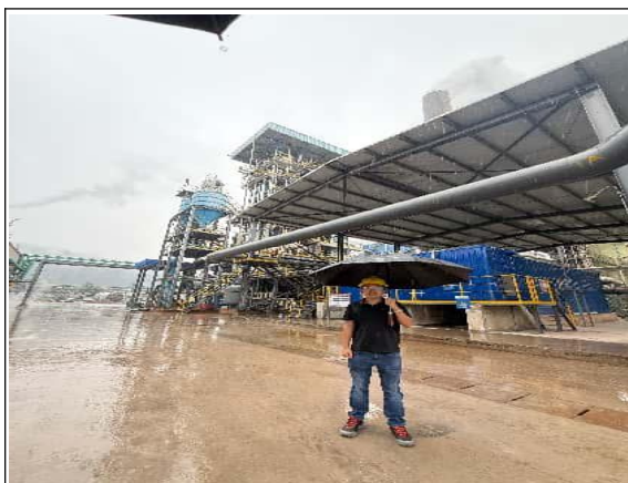
工程师现场踏勘照片（1）
